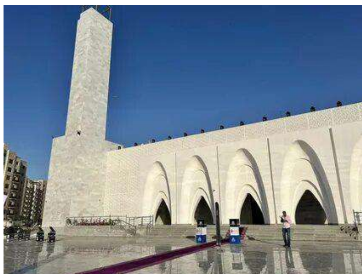
Рисунок 3 – Мечеть в ОАЭ. Строительство началось в 2022 году. Для возведения здания используется роботизированный 3D-принтер, который печатает материалы со скоростью 2 м 2 в час
