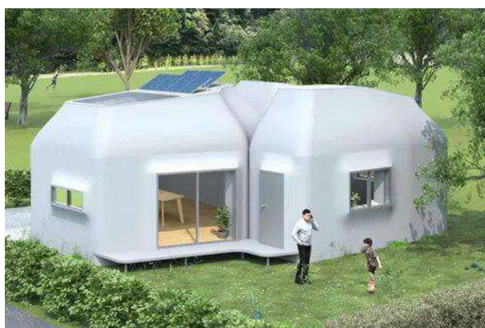
Рисунок 5 – Шарообразный дом в Японии от Serendix. 20-тонный каркас здания изготовлен из бетона при помощи 3D-печати. Дом имеет усиленные стены, соответствующие европейским требованиям к шумоизоляции и японским стандартам сейсмоустойчивости
