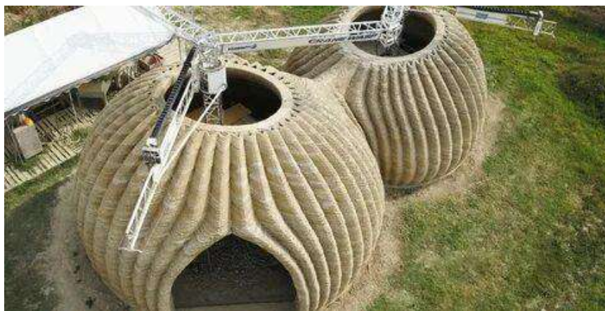
Рисунок 1 – Проект ТЕСЛА (Италия). Компания WASP построила экологичный дом из перерабатываемых материалов с использованием модульного 3D-принтера Crane WASP. Проект направлен на популяризацию строительства с низким уровнем выбросов углекислого газа
