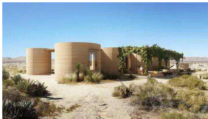
Рисунок 4 – Отель Sunday Homes в Техасе. Компания ICON восстановила заброшенный отель El Cosmico, построив новые здания из бетона с помощью 3D-печати. Они получили цилиндрическую форму и песочную расцветку, чтобы гармонично вписаться в степной ландшафт
