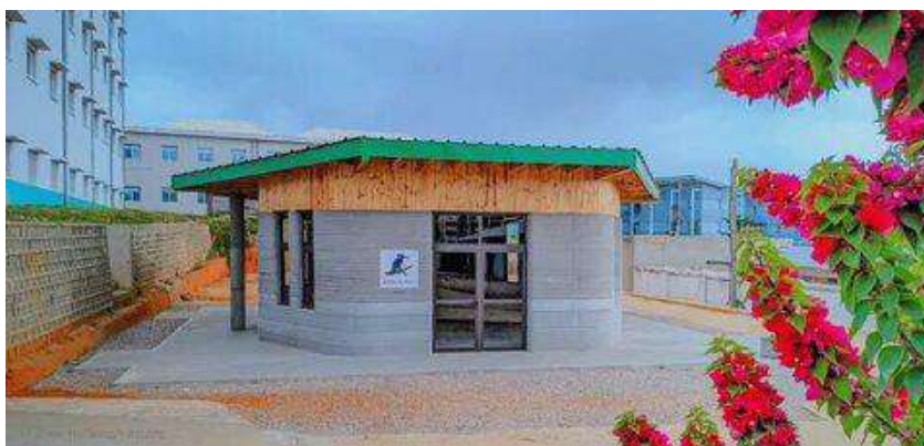
Рисунок 2 – Школа на Мадагаскаре от Thinking Huts. Здание создано с помощью двухметровой роботизированной руки, в качестве материала использовался цемент
