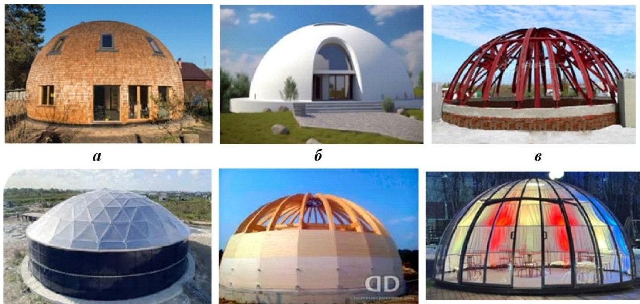
Рис. 5. Классификация купольных покрытий по применяемым материалам [4]: а - каменные; б - железобетонные; в - стальные; г - алюминиевые; д - деревянные; е - полимерные композитные материалы
