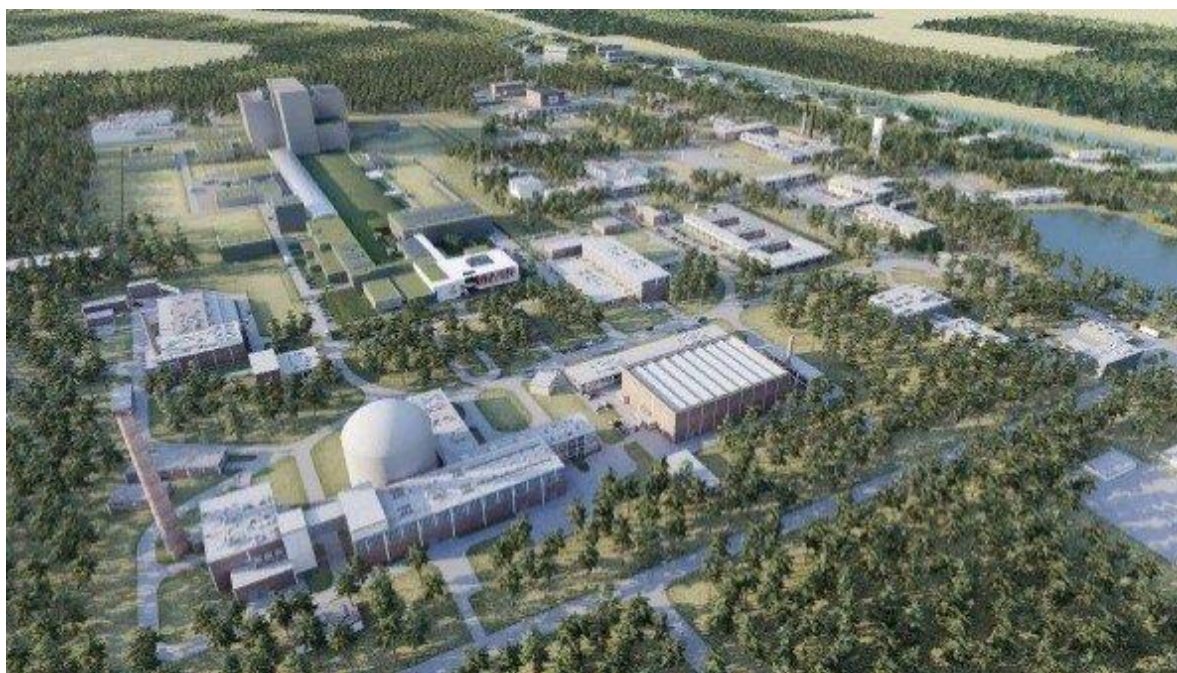
Рис. 2. «MYRRHA» (Multi-purpose hYbrid Research Reactor for High-tech Applications) - первая в мире крупномасштабная ускорительная система (ADS), состоящая из подкритического ядерного реактора, приводимого в движение мощным линейным ускорителем.
