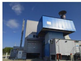
Ремоторизация ГПА-Ц25СД КС «Новоюксенинская» ООО «Газпром Трансгаз Ухта»
