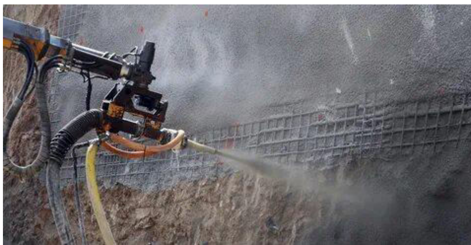
Рис. 1. Торкретирование поверхности
