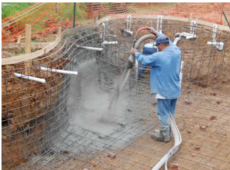
Рис. 2. Применение технологии торкретирования для создания объекта криволинейной формы
