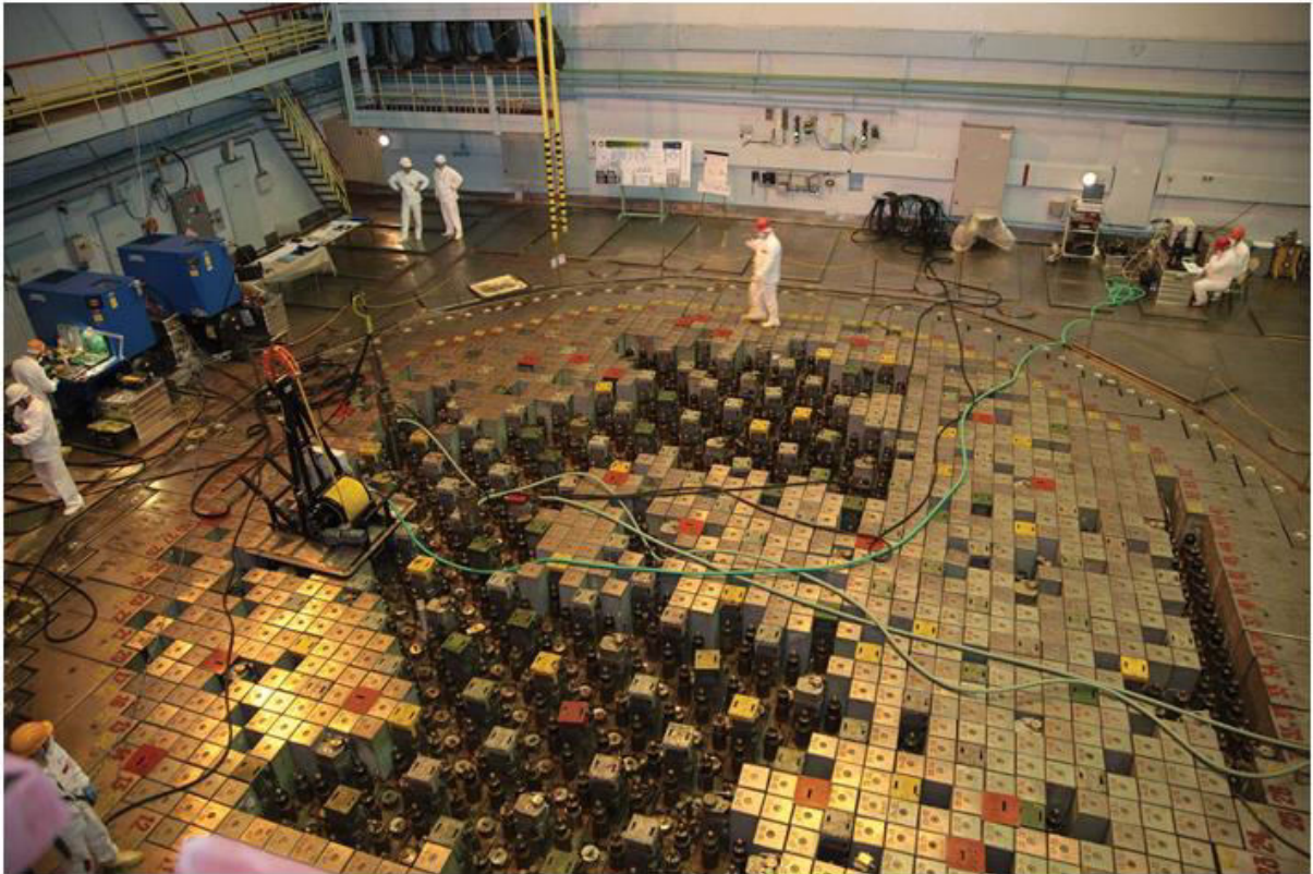
Рис. 2. Демонтаж графитовых кладок
