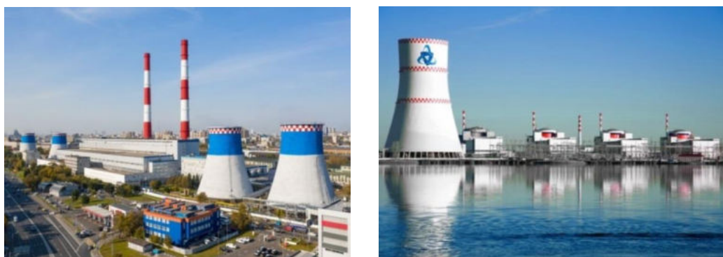
Рис. 1. Общий вид АЭС и ТЭЦ
