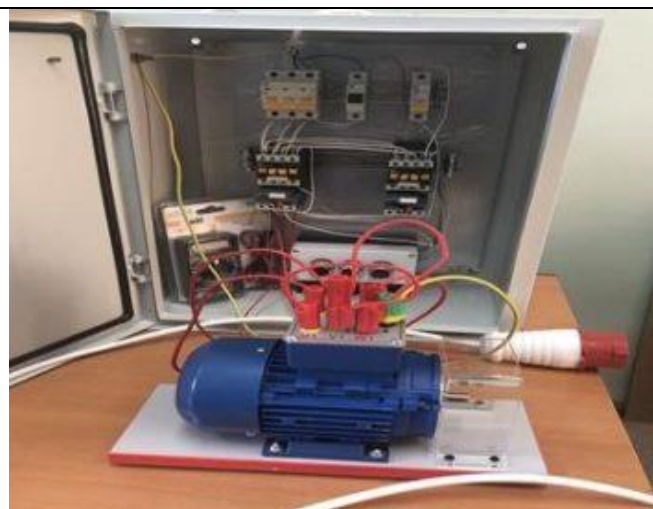
Набор для монтажа в комнате электромонтажника: «Схема управления трёхфазным асинхронным двигателем с короткозамкнутым ротором»
