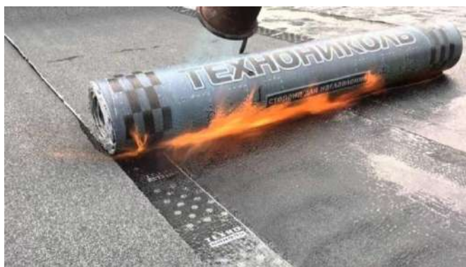
Рис. 6. Покрытие наплавляемой кровлей промышленного здания
