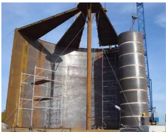
Рис. 2. Пример возведения РВС: а – метод рулонирования; б – листовый метод [2]
