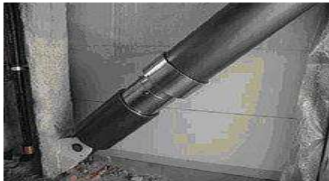
Рис. 9. Гистерезисный, жидкостно-вязкоупругий демпфер в сейсмостойких зданиях
