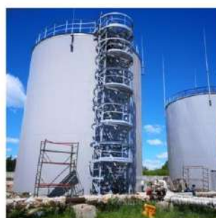
Резервуар объемом 1000 м 3 . Предприятие ГК в "Титан", г. Омск [6]
