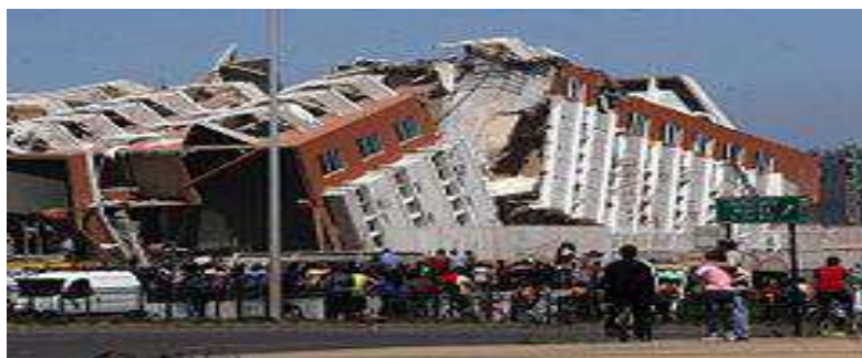
Рис. 1. 20-этажный жилой дом, упавший при землетрясении в Чили в 2010 году
