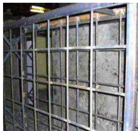
Рис. 3. Армокаркас с продольными рамами жесткости
