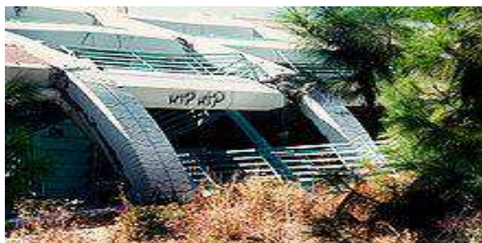
Рис. 2. Гараж в Нортридже после землетрясения 1994 года
