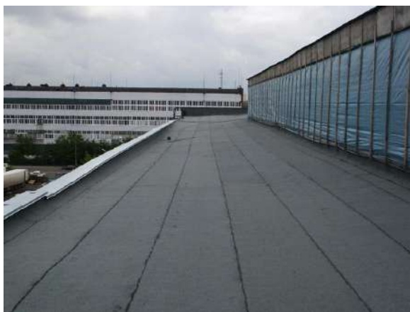
Рис. 5. Покрытие мягкой кровлей промышленного здания
