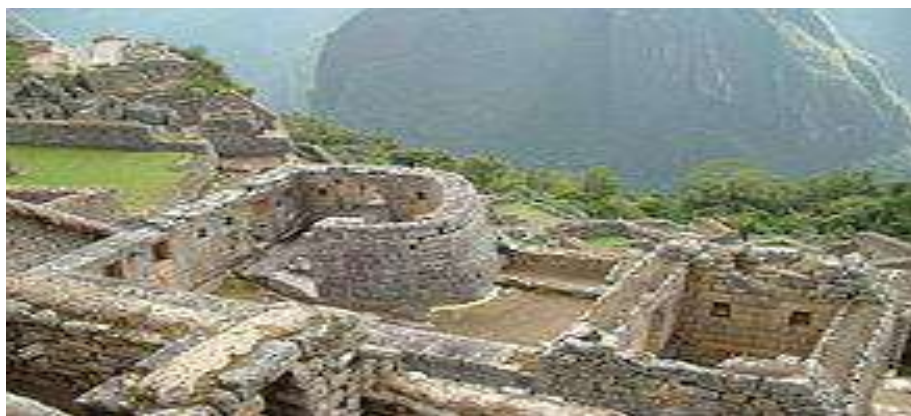
Рис. 4. Безрастворная кладка стен в замке Солнца в Мачу-Пикчу, Перу
