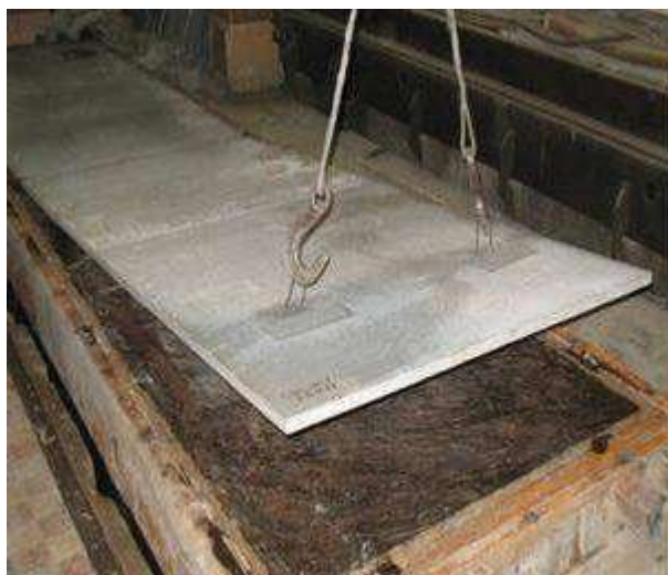
Рис. 1. Распалубка сталефибробетонного листа толщиной 30 мм
