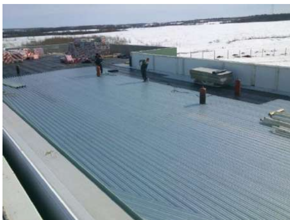
Рис. 3. Покрытие профнастилом промышленного здания
