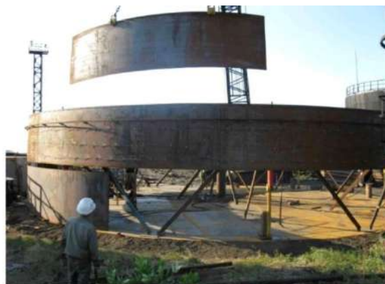
Рис. 2. Пример возведения РВС: а – метод рулонирования; б – листовый метод [2]
