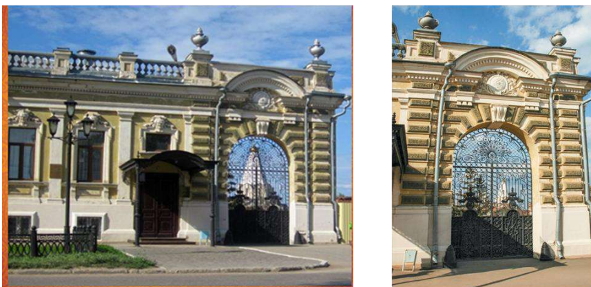
Рис. 2. Фрагменты архитектуры фасада с торжественными рустованными въездными воротами и величественным аттиком
