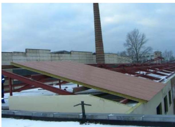
Рис. 2. Покрытие сэндвич-панелями промышленного здания
