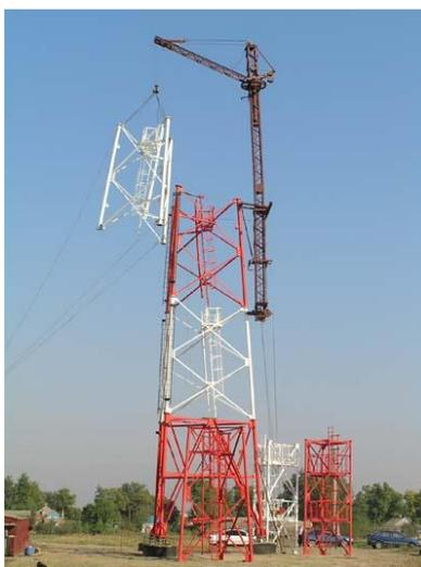
Рис. 3. Монтаж башни сотовой связи высотой 52 м в городе Краснодар [6]
