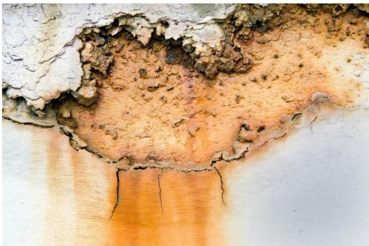
*Рис. 7. Воздействие физико-химической коррозии на бетон*
