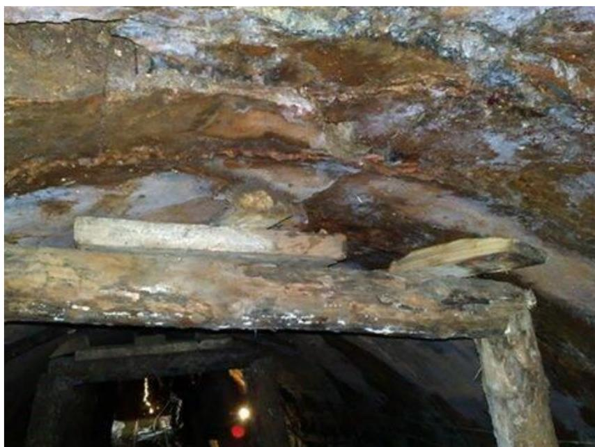
*Рис. 3. Разрушение подземных сооружений под действием агрессивных вод*
