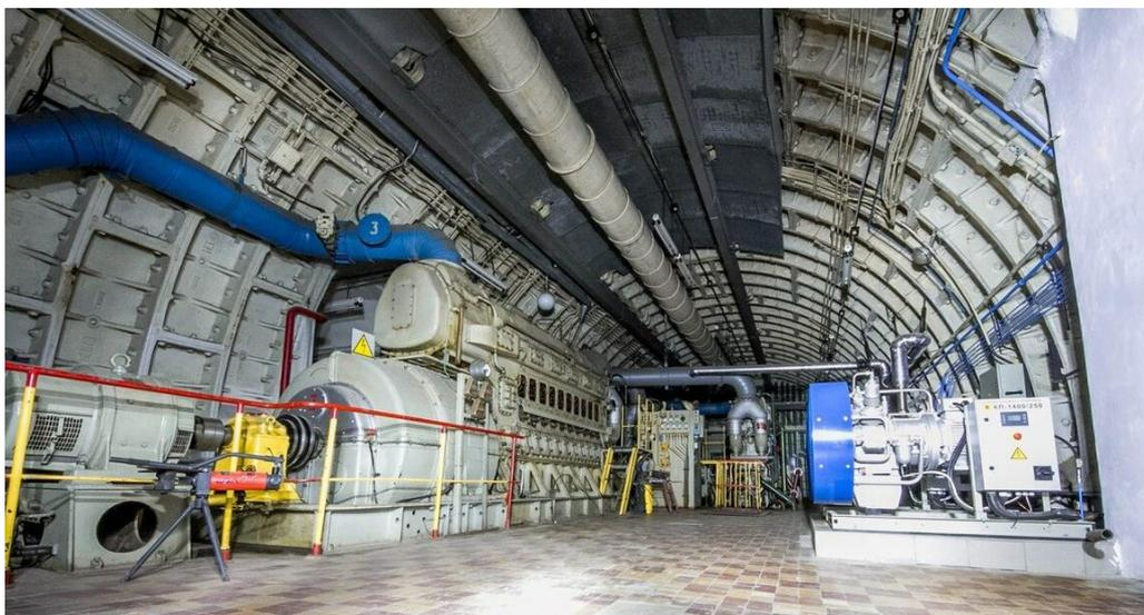
Рис. 1. Резервная дизельная электростанция с дизелями 64Г на одном из объектов Санкт-Петербургского метрополитена
