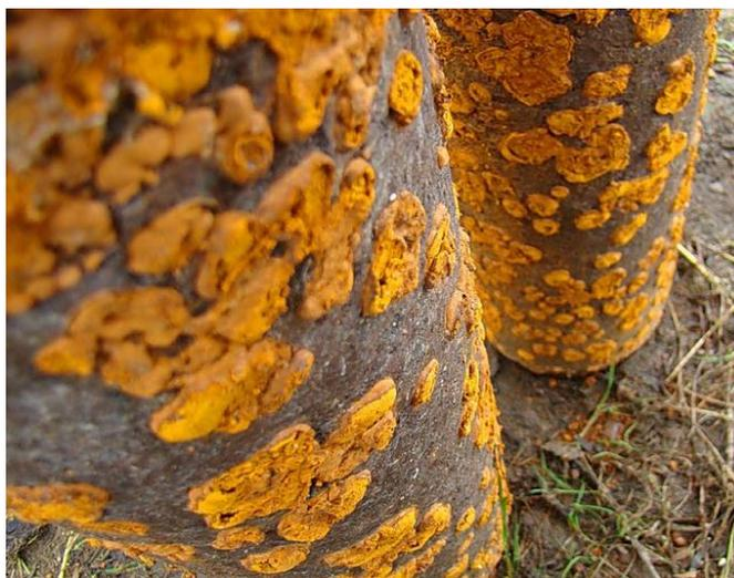
*Рис. 8. Разрушение бетонных конструкций под действием биологической коррозии*
