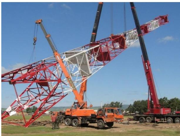
*Рис. 6. Монтаж вышки связи поворотом вокруг шарнира, г. Семей [7]*
