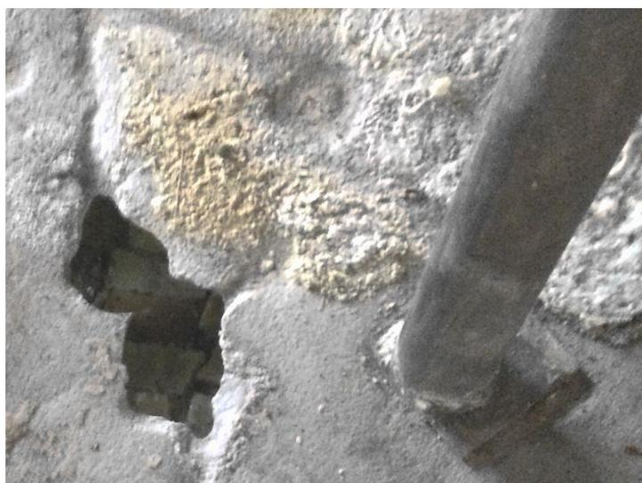
*Рис. 5. Кислотное разрушение бетонного камня*
