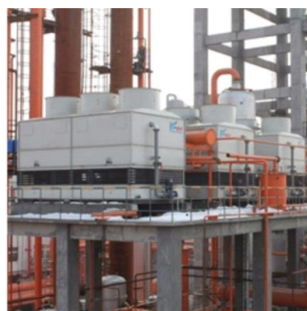
Рис. 4. Закрытая испарительная градирня [5]: а – MESAN MST-7100/7200; б – действующая градирня, Россия
