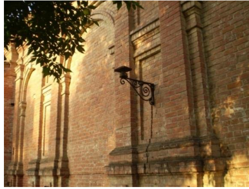
Рис. 10. Брандмауэр, отделяющий липовый сад от хозяйственного двора Вверху: общий вид, внизу фрагмент модуля стены с рельефом арочной ниши; металлический фигурный кронштейн для фонаря. Элементы несут черты стиля ренессанса
