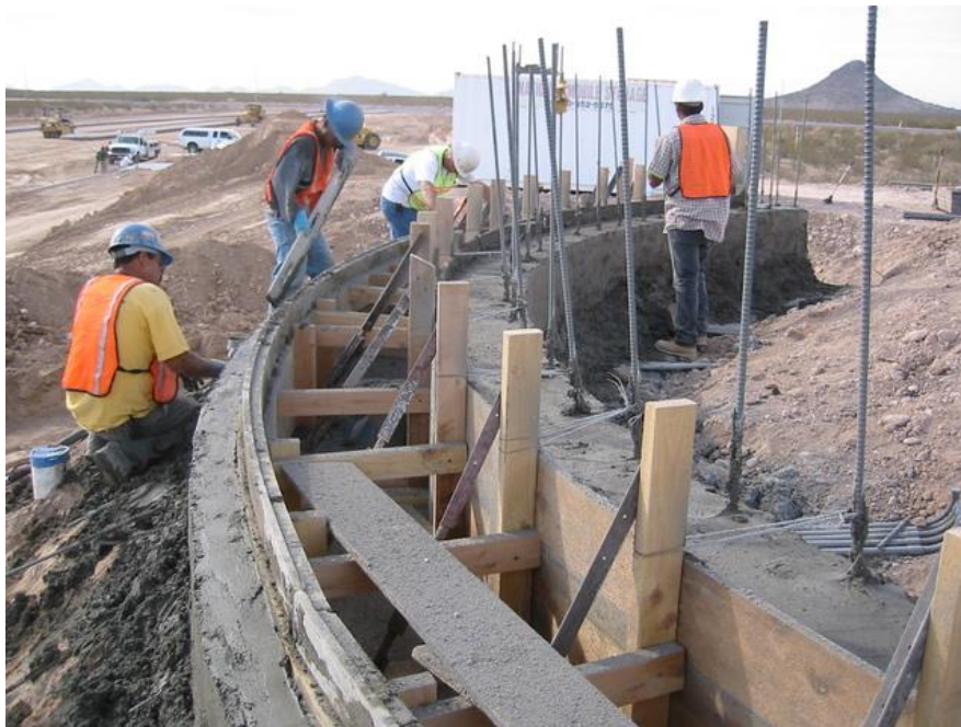
Рис. 4. Конструкция стенки монолитного резервуара, выполненная методом торкретирования
