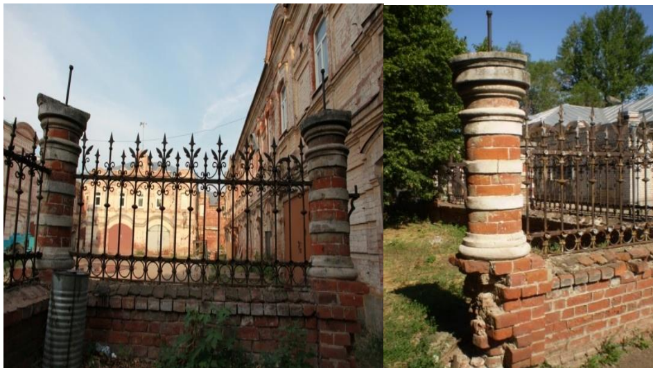
Рис. 6, 7. Металлическая внутренняя ограда липового сада. Руины кладки. Середина-конец XIX в. Фото 2020 г.
