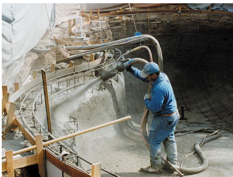
Рис. 3. Конструкция бассейна, выполненная методом торкретирования
