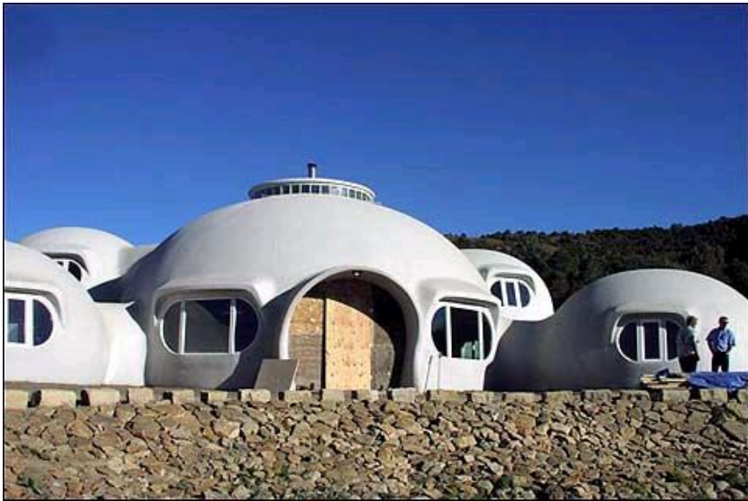
Рис. 1. Конструкция полусфер, выполненная методом торкретирования
