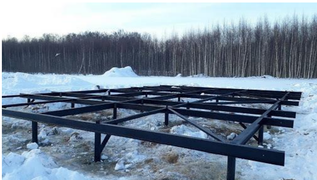
Рис. 1. Устройство фундаментов
