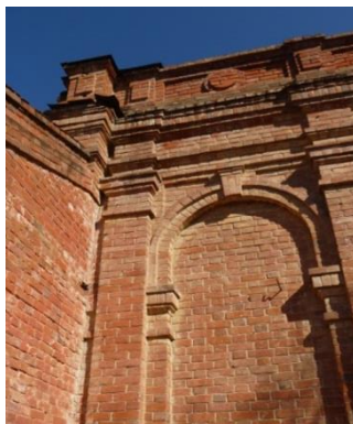
Рис. 10. Брандмауэр, отделяющий липовый сад от хозяйственного двора Вверху: общий вид, внизу фрагмент модуля стены с рельефом арочной ниши; металлический фигурный кронштейн для фонаря. Элементы несут черты стиля ренессанса
