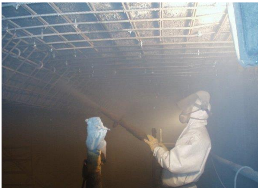
Рис. 2. Конструкция туннелей, выполненная методом торкретирования
