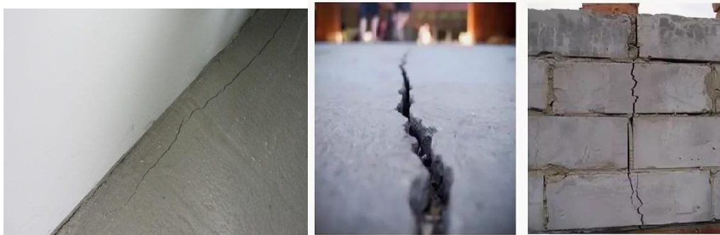
Рис. 3. Образование трещин при усадке бетона: а – усадка бетона в готовом изделии; б – усадка при стяжке полов; в – образование трещин в несущих конструкциях
