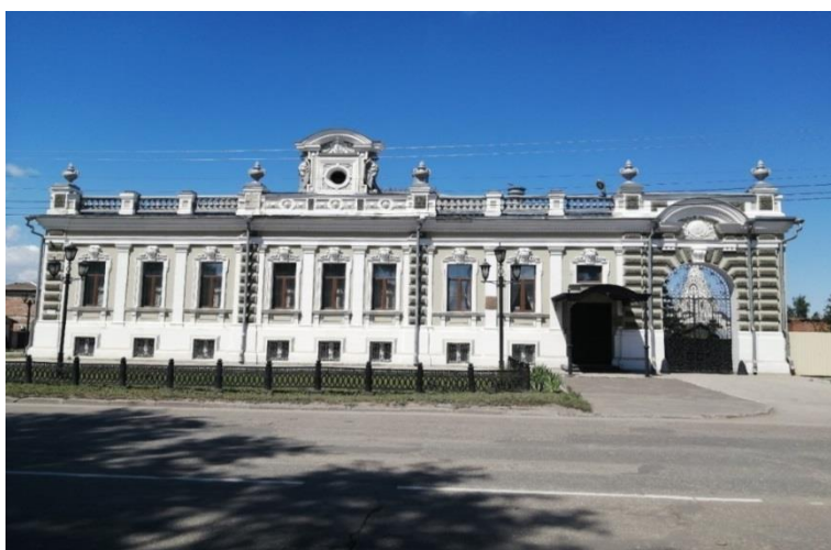
Рис. 2. Северный фасад дома с ул. Коммунистической (2020)
