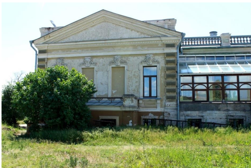
Рис. 5. Фрагмент 1 южного фасада дома (2019)
