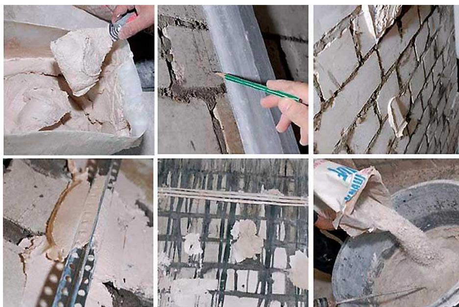
Рис. 3. Применение фосфогипса для отделочных работ
