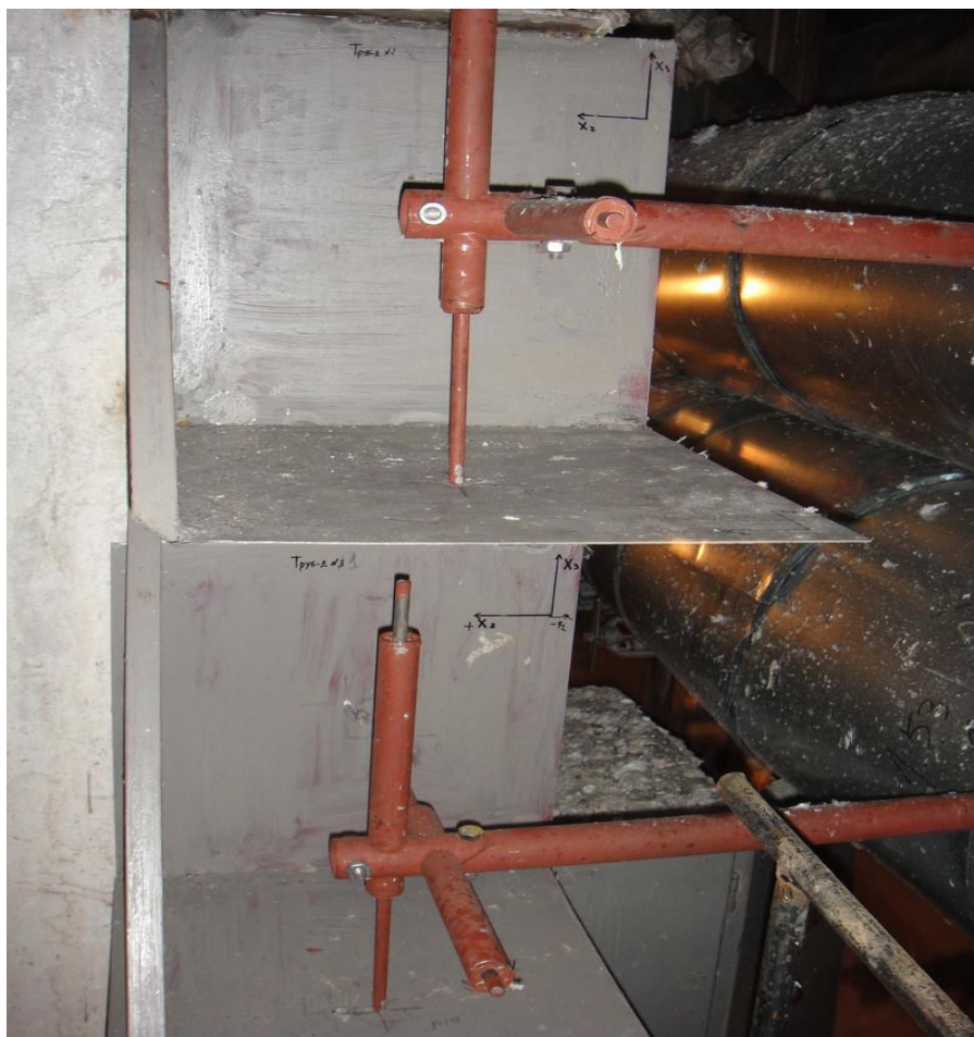
Рис. 4. Визуализация индикаторов перемещений трубопроводов
