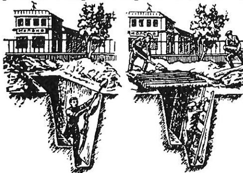
Рис 1. Устройство простейшего укрытия (щели).
