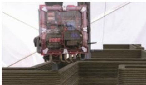
Рис. 10. Процесс печати 3D-принтером StoryBot
