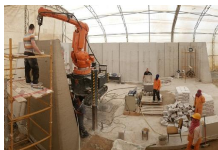
Рис. 6. Постройка мобильный вариант RC 3Dp на гусеницах лаборатории в Дубае R&Drone
