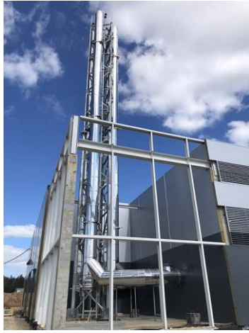
Рис. 4. Башня-труба с тремя стволами: а – возведенная в п. Есипово; б – возведенная в г. Дымере
