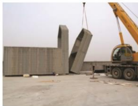
Рис. 4. Процесс сборки напечатанного 2-этажного дома
