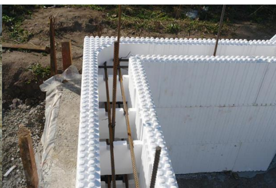
Рис. 3. Опалубка из пенополистирола
