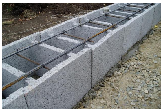
Рис. 2. Опалубка из арболита
