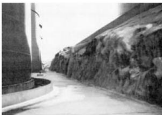
Рис. 1. Часть укрепленной поверхности горной породы на нефтеперерабатывающем заводе города Брофйорден, Швеция
