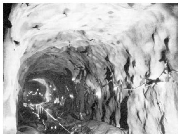
Рис. 2. Облицовка аварийного туннеля по добыче водоугольного топлива атомной электростанции «Ринглас» в Швеции
