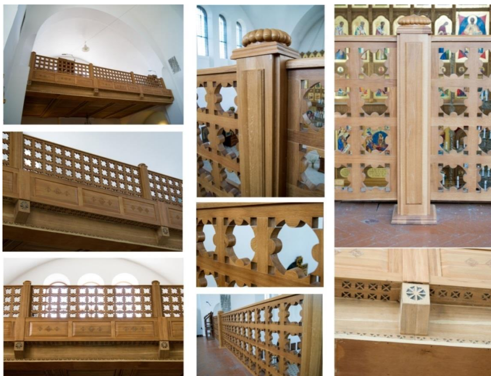
Рис. 6. Вид шехтелевских реставрированных деревянных хоров: решеток ограждений, элементов и деталей столбов, орнаментов резьбы
