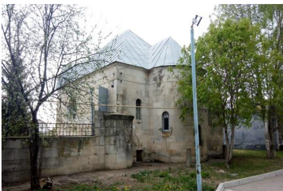
Рис. 3, 4, 5. Фото фасадов причтового дома Свято-Троицкого храма. Дубнов С.
